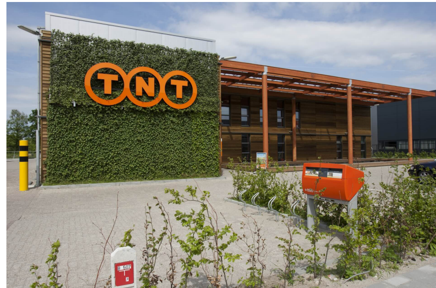
groene gevels met een duurzame uitstraling op zichtlocatie
