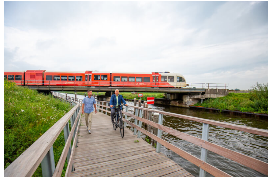
functionele onderdoorgang langs de trekvaart Stroobos, Friesland
