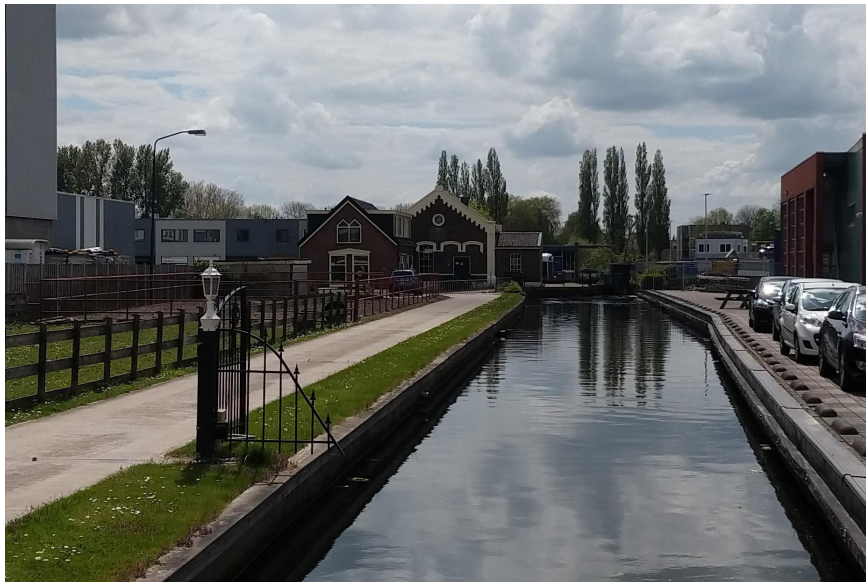
het ingesloten oude gemaal aan de Molenvliet
