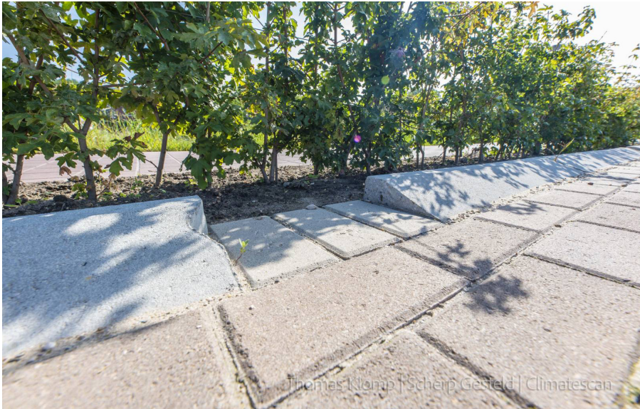
Afbeelding 3.11 Optie toepassing wadiband of uitsparing in band om oppervlakkige afstroom naar wadi mogelijk te maken
