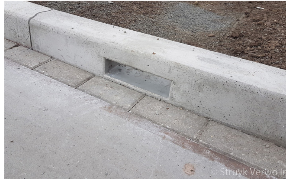
Afbeelding 3.11 Optie toepassing wadiband of uitsparing in band om oppervlakkige afstroom naar wadi mogelijk te maken
