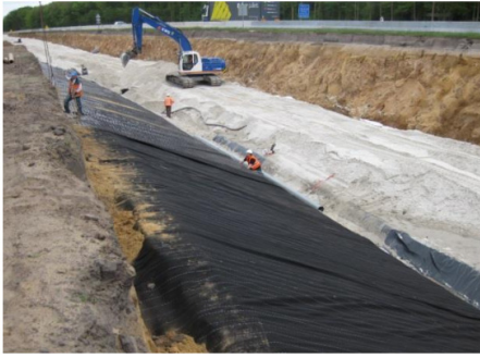
Afbeelding I.1 aanleg folieconstructie N33 Gieten
